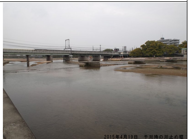
大潮干潮時も断流にならず、遡上通路は残されている。
