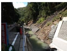
僧川改修工事中の護岸崩壊
