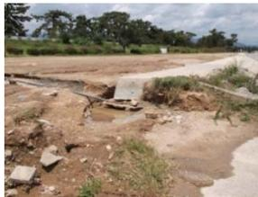
床低下流の仕様変化による洗掘
