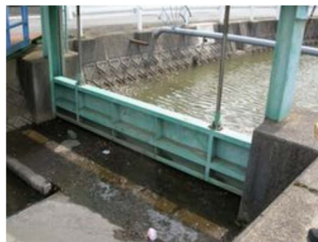
田松川谷中分水界水門
