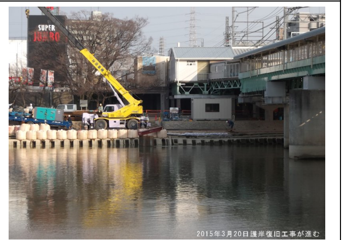
橋脚部分埋め戻しが終わり低水護岸の復旧工事が始まった。
