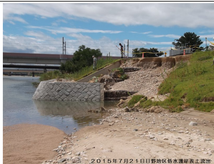
2015年7月21日日野地区低水護岸表土流出
