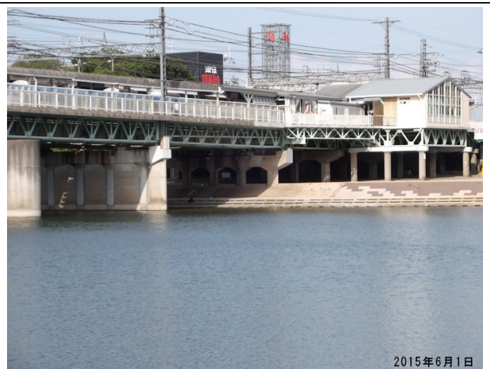
長期間堰を転倒して復旧補強工事を終えた阪神橋梁と護岸
