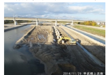
2014/11/29 甲武橋上流側 西宮市右岸甲武橋上流側
