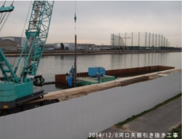
武河口矢板引き抜き工事
