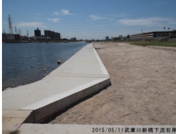
武庫川新橋下流右岸
