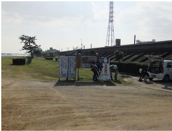
11月18日から掘削工事が始まる旨掲示板が立てられた。
