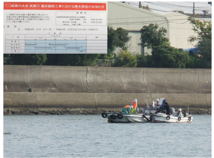
11月1日より浚渫工事が終わった区間の潜水調査が始まった。
