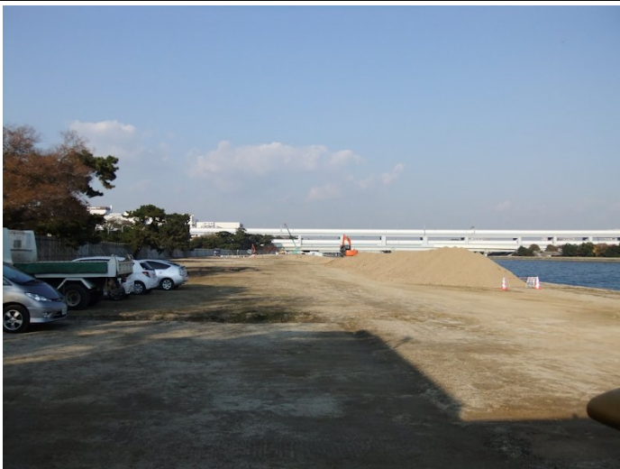
第2工区に設けられたインフォメーションセンターから見た工事の様。掘削した所から矢板打ちが始まった。
