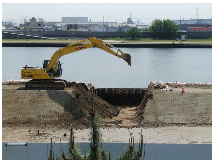
⑤掘削が進む河口第1工区。砂が現れるところまで掘削
