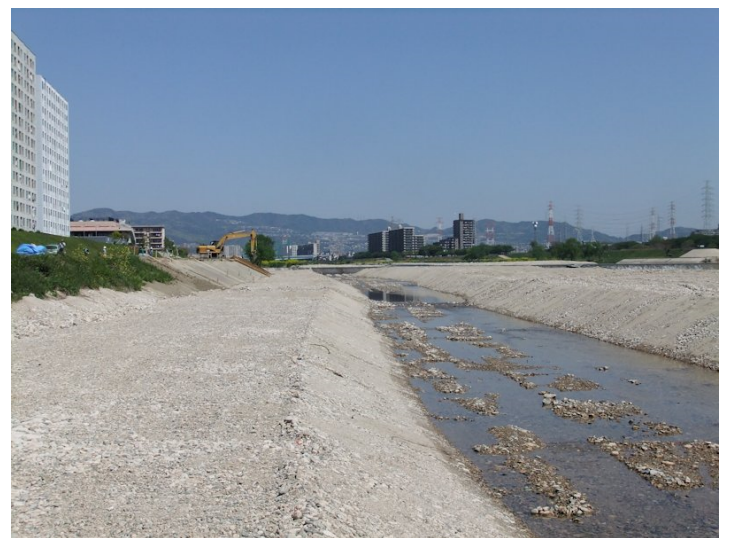
④仁川合流点上流の河床掘削状況 川の中はどうか？
