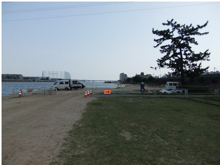
③第1工区掘削工事用塀が撤去された。
