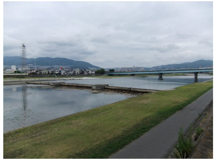
②河床掘削後百軒樋
