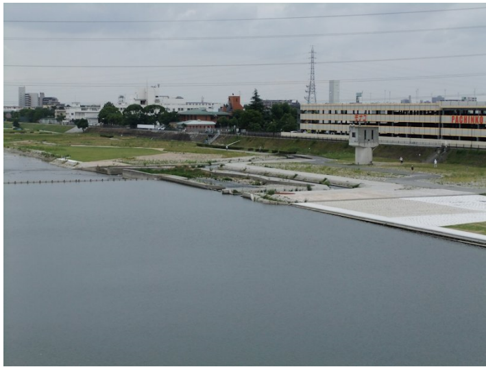
①百軒樋 18号台風復旧工事終了
