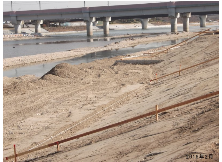
左と同一場所の復旧状況。水標下の柳抜き取られた。
