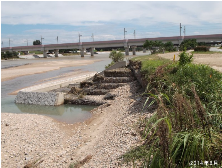
11号台風直後の日野地区護岸被害状況
