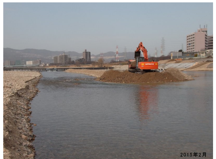
第8堰直下の浚渫工事。浚渫土砂は左岸高水敷集積。
