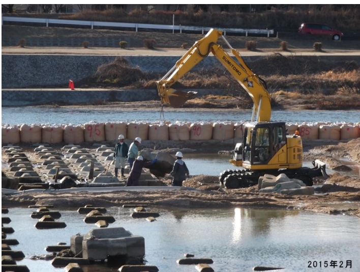
第3堰床止め工復旧状況
