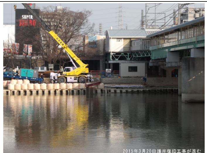
2015年3月20日護岸復旧工事が進む
