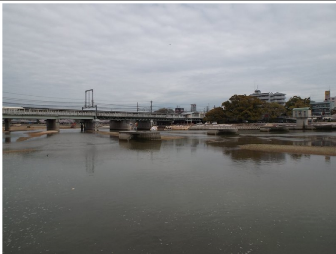
③堰の下流側から見たところ。阪神橋梁水位計の下に砂州が広がっている。
