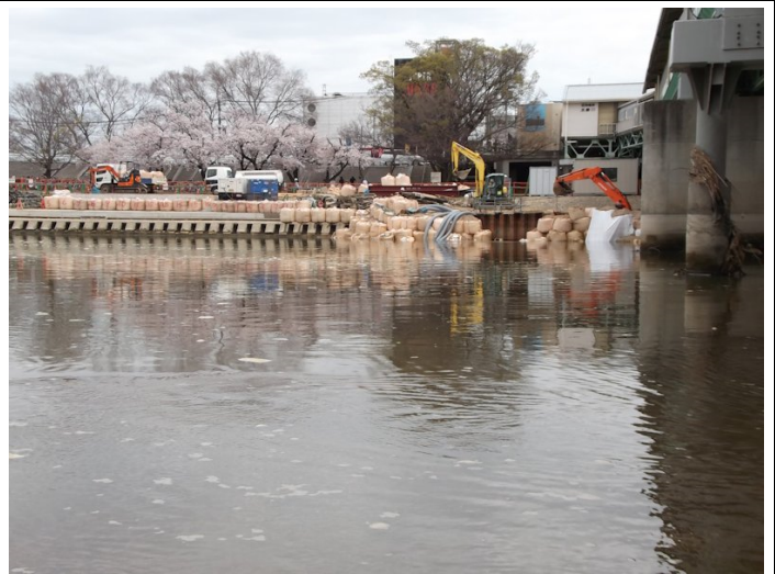
④阪神橋梁護岸復旧工事が続いている。
