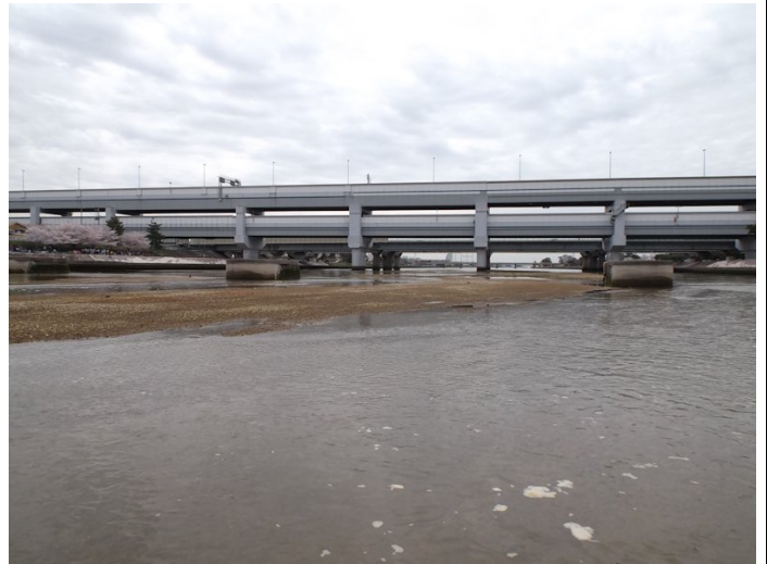
②堰の上流側にも砂州が広がっていた。
