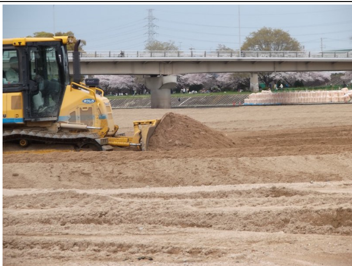
⑤武庫川橋少し上流側から阪神橋梁間の堆積土砂を平らにならす工事が行われていた。
