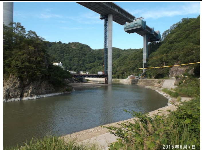
豊水期を迎え河川工事は止まるが新名神工事は続く。
