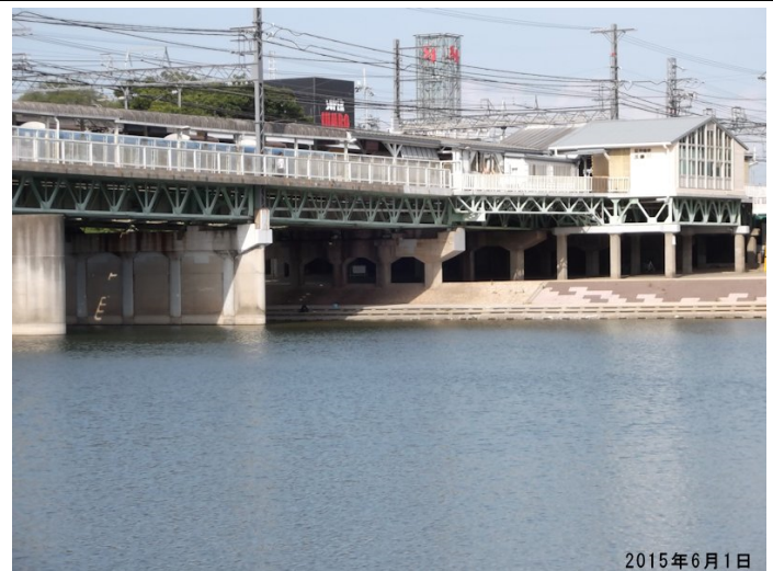
長期間堰転倒して復旧工を終えた阪神橋梁護岸
