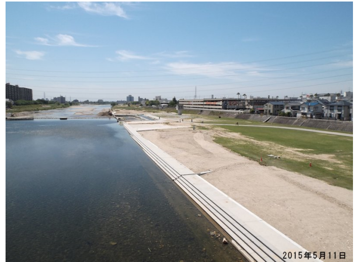
二年連続被害を受けて復旧を終えた百軒樋護岸
