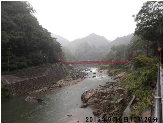
写真1 武田尾上流方向
