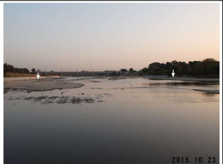
ブロックが平坦な流れを変え中部に水脈筋を作った。
