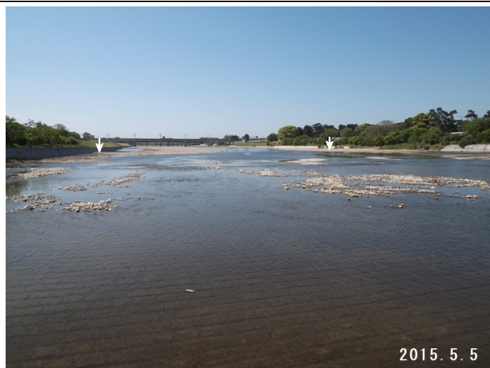
5 堰下流浚渫直後。矢印の箇所にブロックが置かれた。
