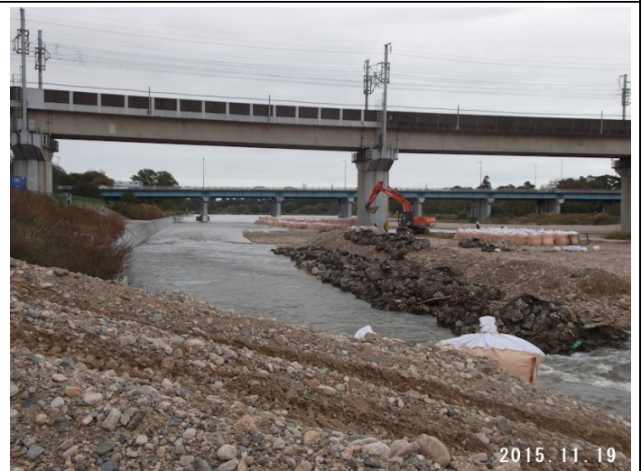
甲武橋上流堤防強化工事床止めブロック敷設
