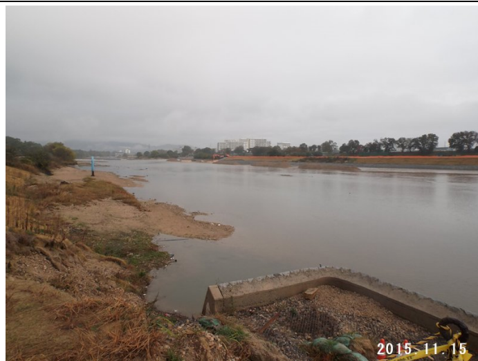
日野地区災害復旧工事始まる。床止めブロック敷設
