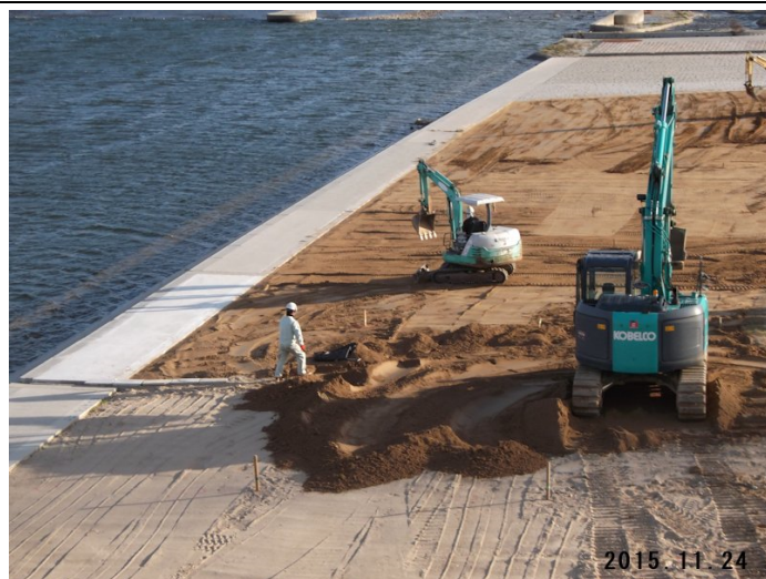
新橋下流側で河川公園工事が行われていた
