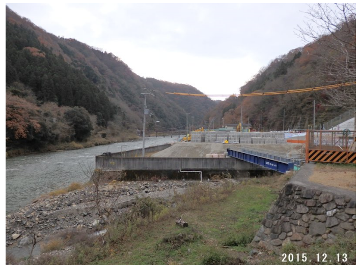
武田尾嵩上げ工事
