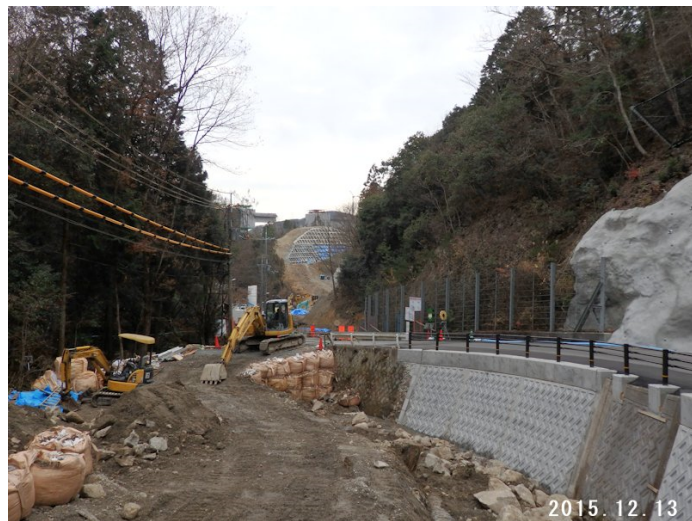
宝塚SA侵入道路・切畑線拡幅。僧川改修工事
