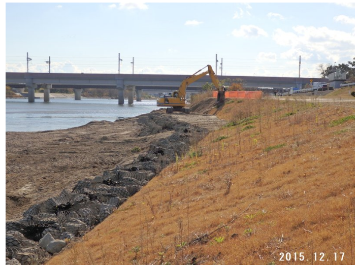
日野地区復旧状況 床止め（河川ネット）再利用。
