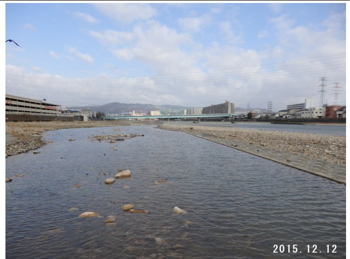
百軒樋 下流高水敷を流れていた
