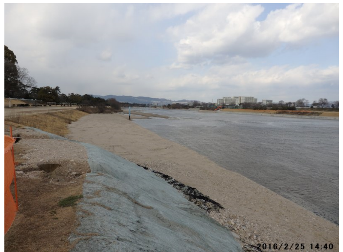
日野地区 仮設堤の土砂はここに積み上げられた。
