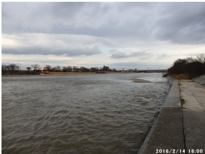
6号堰（低水護岸工事が終わり河床も平坦された）
