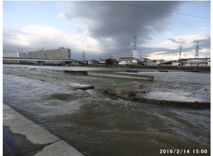
百間樋堰から溢れる濁流
