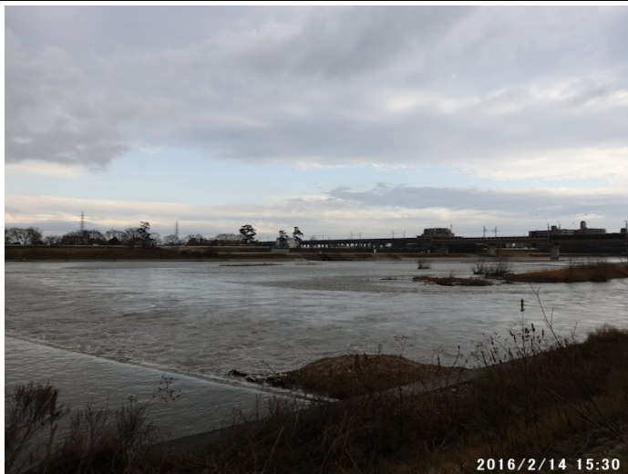
7号堰（低水護岸工事ご最初の出水）
