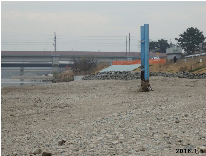
日野地区の袋型根固め材が積み上法面はシート張り
