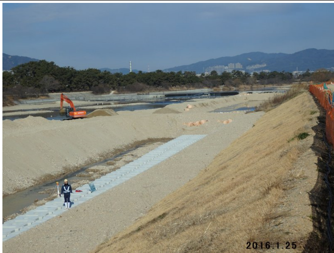
武庫工区の床止め工事は終盤を迎え河床ならし作業開始
