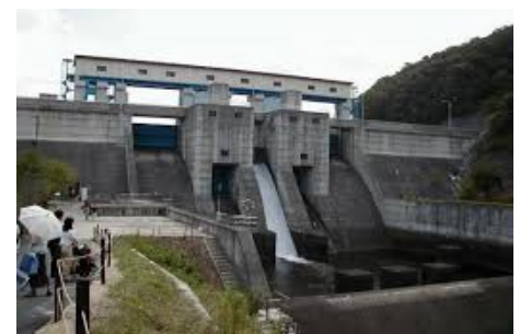
多目的ダムである青野ダムの堤体
