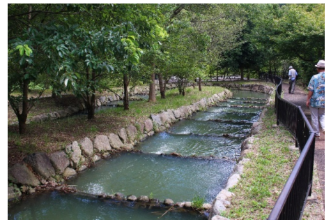
青野ダム多自然型魚道
