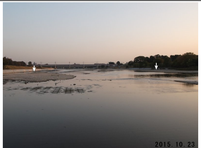
ブロックが平坦な流れを変え中部に水脈筋を創出
