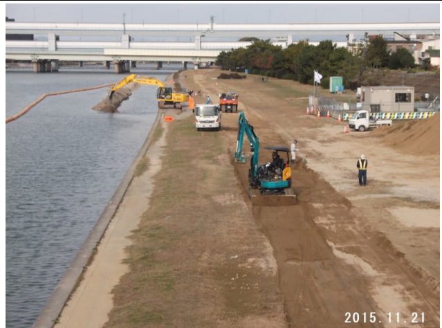
南武橋付近の下水管工事終了 護岸工事開始
