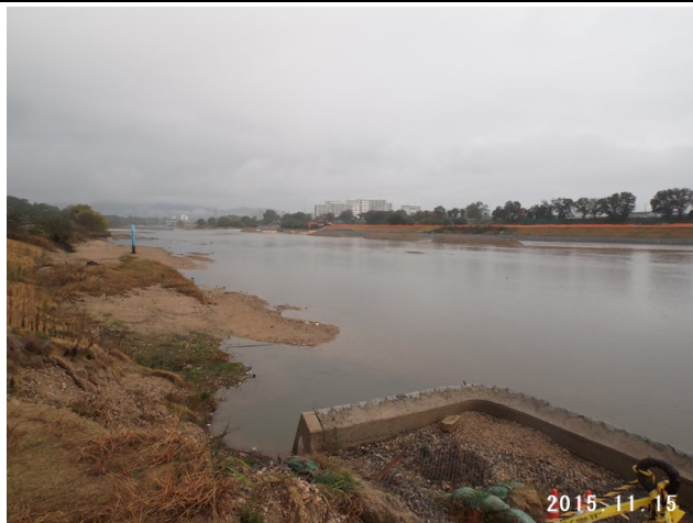
日野地区災害復旧工事着工 床止めブロック敷設
