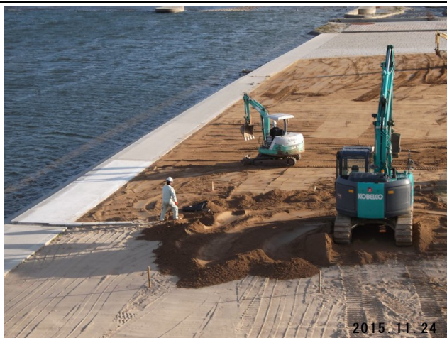
武庫川新橋下流側の河川公園工事
