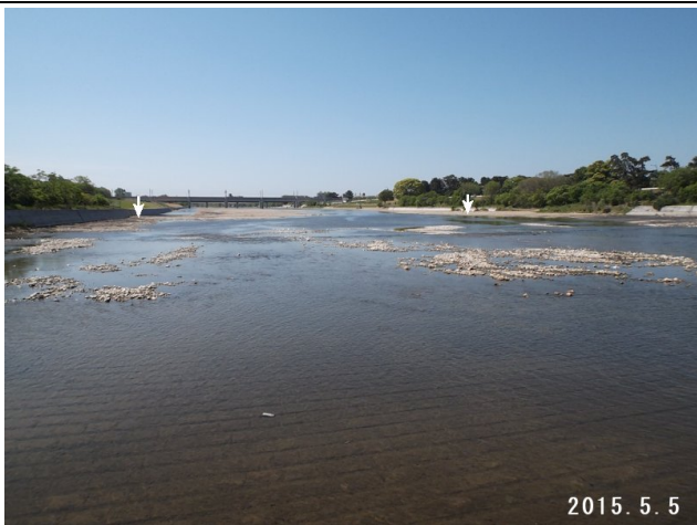
第5号床止下流浚渫直後 矢印の箇所にブロック設置
