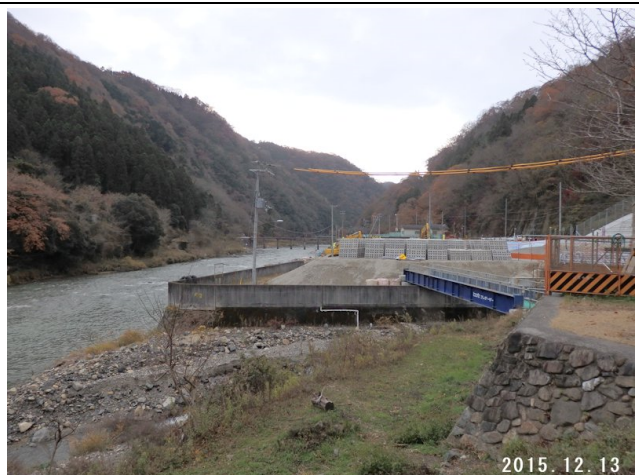
武田尾嵩上げ工事
