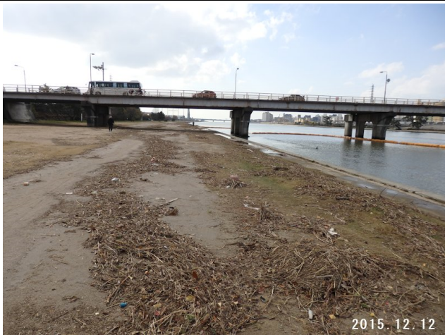
南武橋上流左岸の流跡痕
