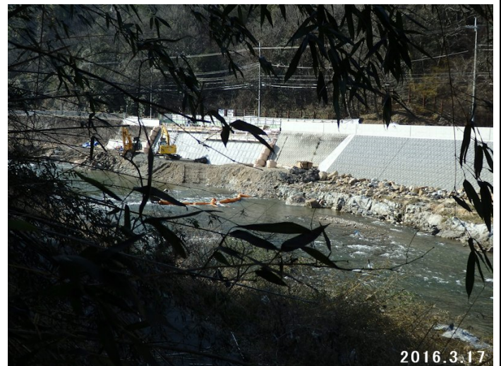
平野浄水場上流付近の護岸復旧工事が行われた
