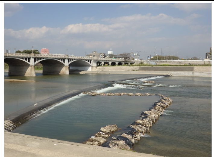
4月19日甲武橋水位 0.76m時の2号堰の様子
