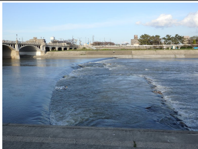
4月14日甲武橋水位 1.22m時の2号堰の様子
