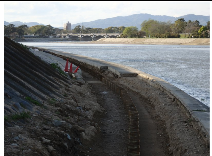
第1堰下流右岸の矢板打工事。
