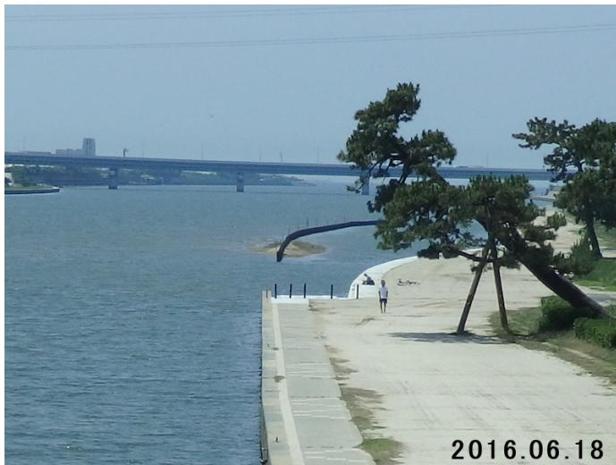
抜けなかった矢板付近に砂州が出来始めた。
