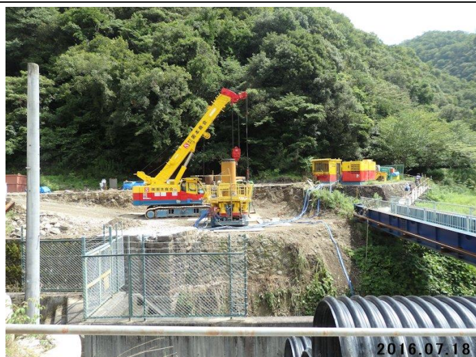
武田尾峡谷ハイキング道橋梁架け替え工事中
