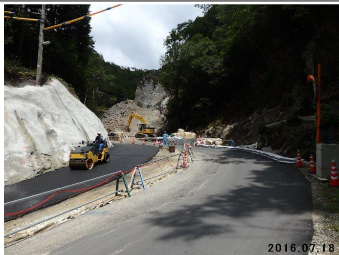
武田尾～西谷間の県道拡幅工事で開削された谷
