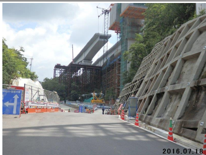
昔の面影を微塵も残さない出合橋
