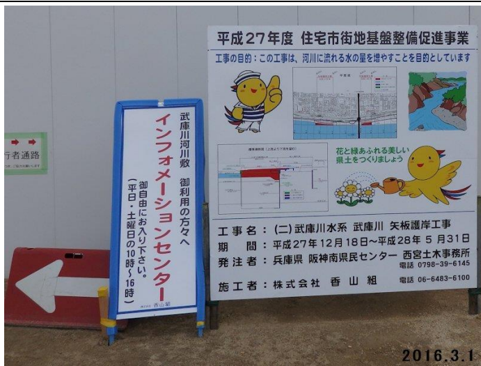
河口部では矢板護岸工事と浚渫工事中
