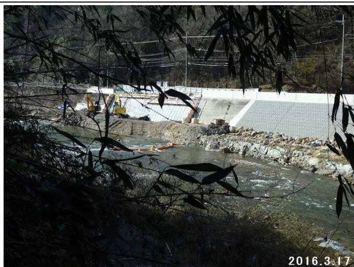
平野浄水場上流付近の護岸復旧工事
