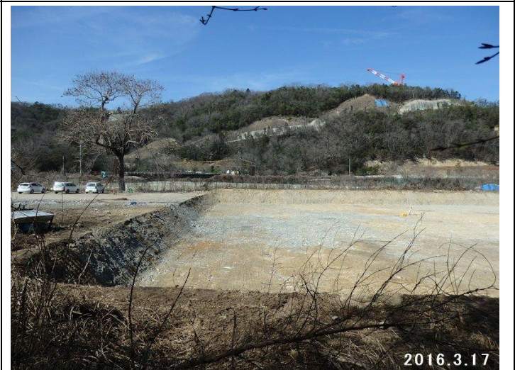
遊水池掘削工事現場
