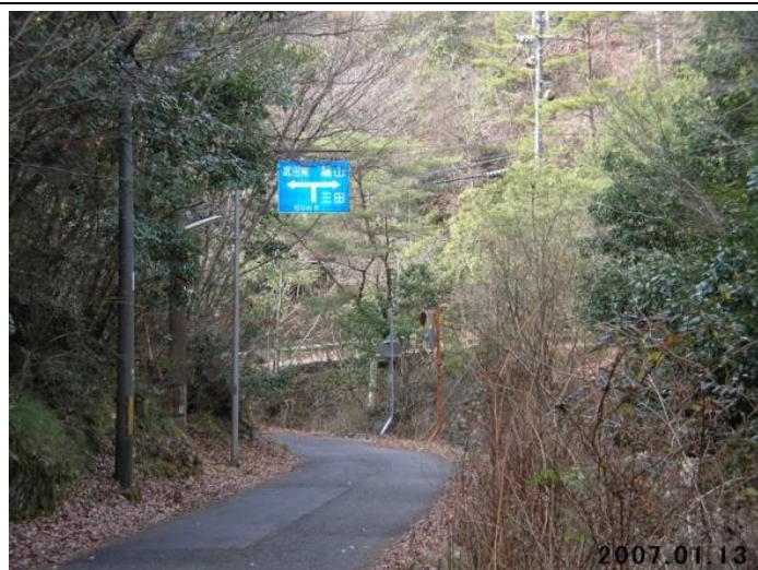
工事前の出合橋
