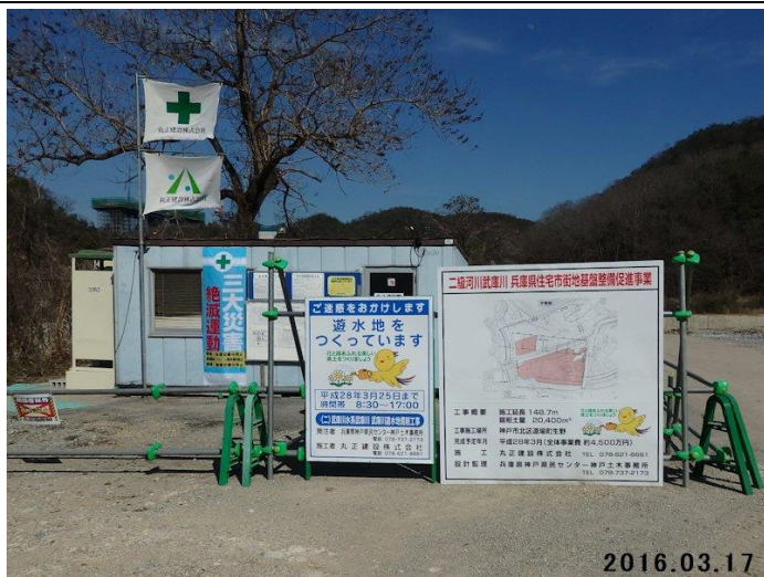
上流浄化センター下流で遊水池工事着工
