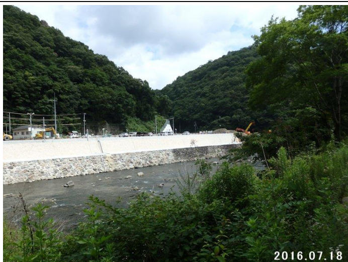
僧川合流付近を残して嵩上げ工事は終了
