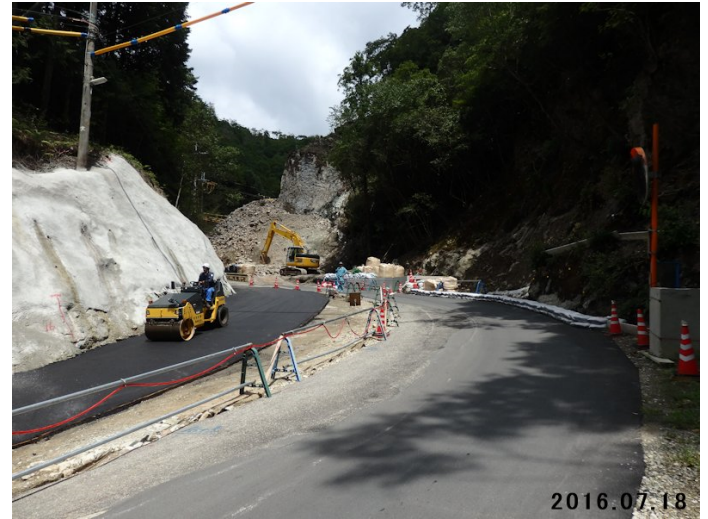
武田尾～西谷間の県道拡幅工事で谷が切り開かれている
