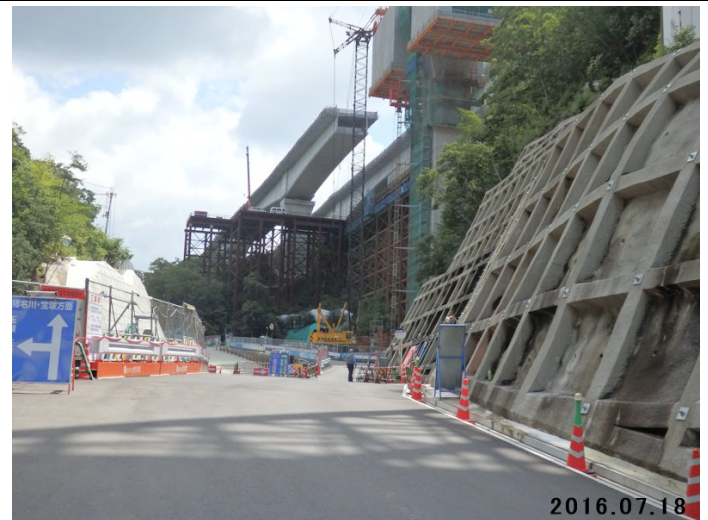
昔の面影を微塵も残さない出合橋
