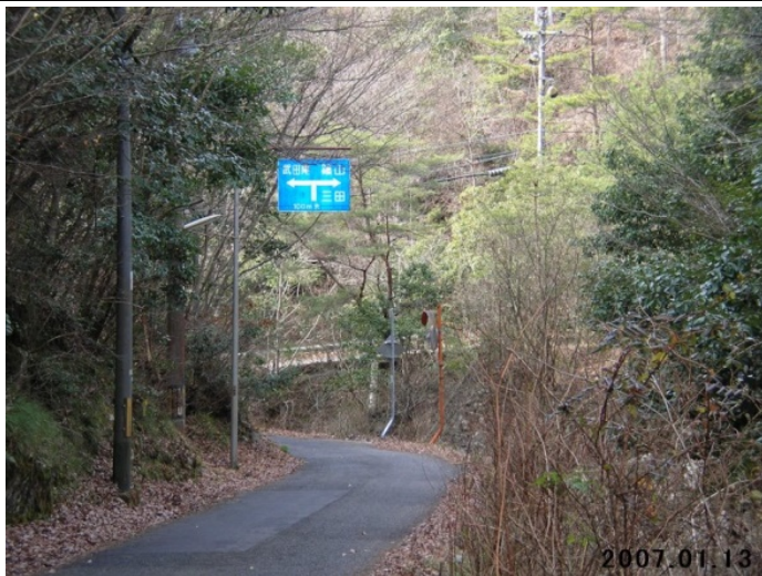
工事前の出合橋
