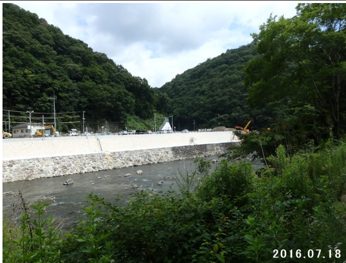
僧川合流点付近を残し嵩上げ工事は終わった。
