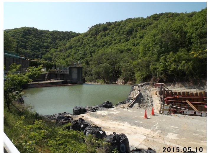
堰だけが原型を止めた僧川水源地
