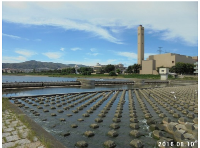
混陽井 右岸の魚道を流れる水と混陽井取水量が全水量
