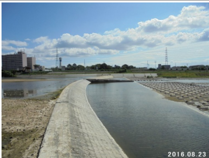
第8堰 右岸低水護岸脇に低水温の溜まりがあった
