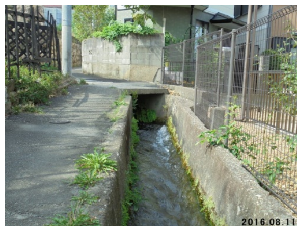
六甲トンネル湧水排水溝
