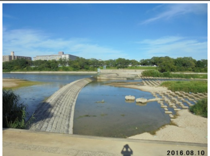
水量管理基準点の甲武橋の流れは魚道だけになっていた。
