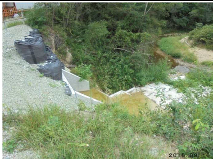
掘込み河川法面の真新しい放流口
