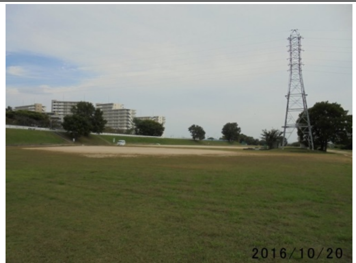
野球ネット撤去、堤防際で矢板打設工事説明板が立った。
