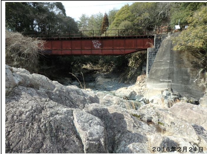
名塩川合流点鉄橋改修前
