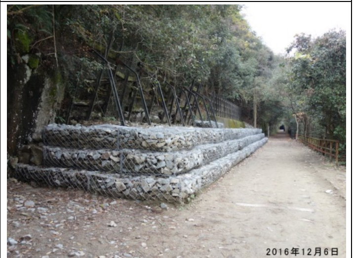
土砂崩落対策工事と樹木伐採で一変した風景。
