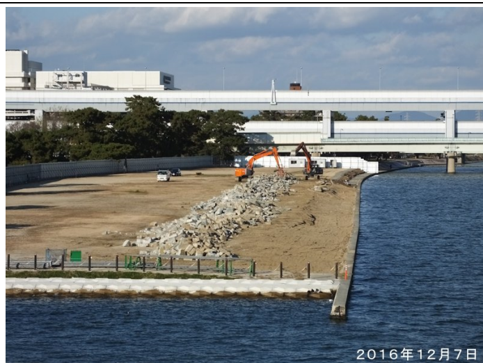
南武橋上流側で拡幅工事が始まった。
