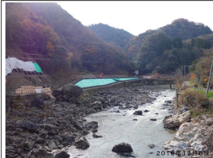
武田尾温泉嵩上げ工事が進み温泉風景が一変した。
