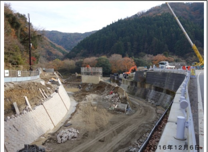
僧川合流点で大規模な拡幅工事が行われていた。
