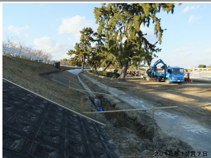
武庫大橋右岸下流側の堤防補強工事の様様
