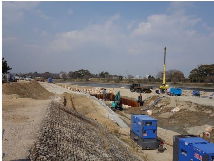
小松工区（矢板打ち&低水護岸工事）
