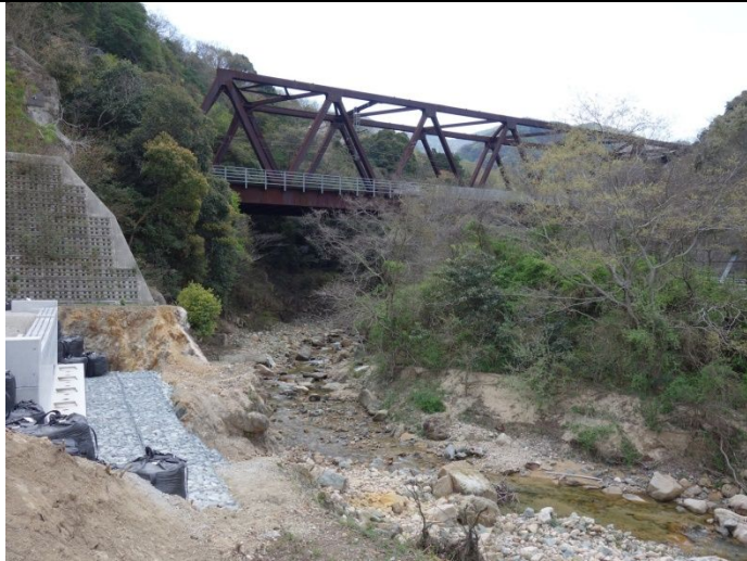
大多田川合流部で名塩道路建設工事が始まっていた。
