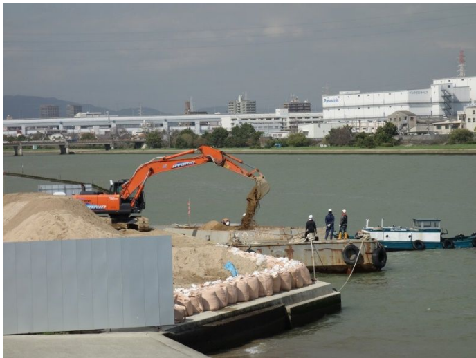
掘削土砂が台船で搬出されている。行き先は分からない。
