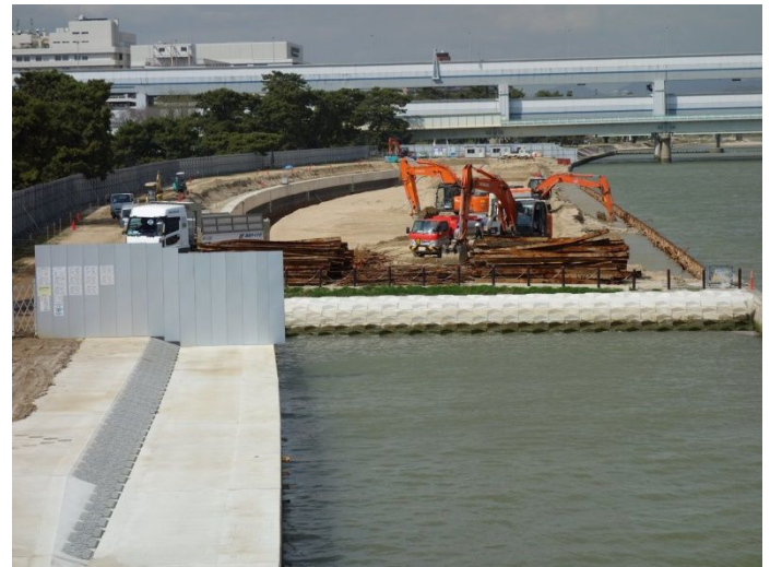
43号線橋梁河口側左岸拡幅工事現場掘削工事始まる。
