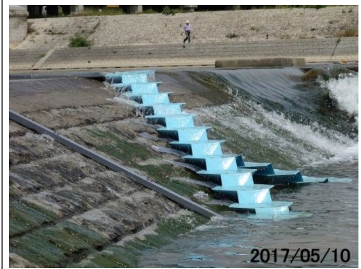
鋼製魚道設置直後
