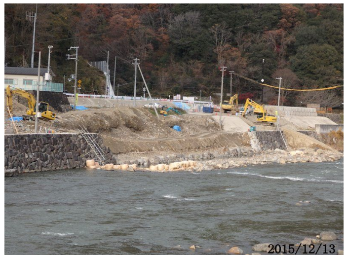
武田尾住宅地区護岸復旧工事の様子
