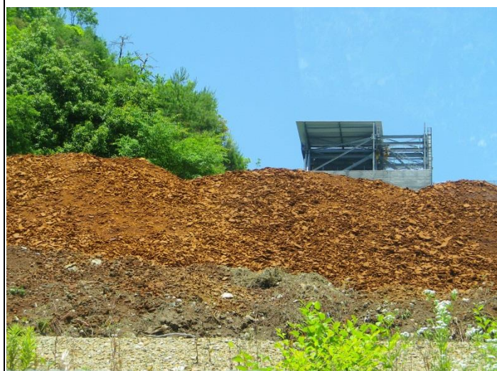
工場からの排出汚泥が積上げられた大岩橋下流左岸
