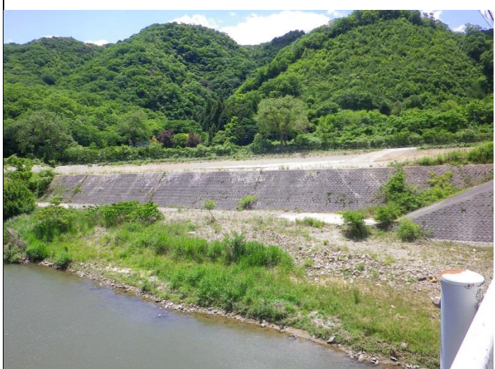
大岩橋から見た掘削工事が進行する遊水地
