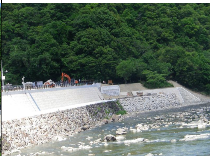
区画整理事業と僧川流入部の河川整備が完了した武田尾
