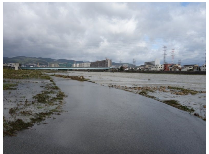
百間樋余水吐口下流付近から上流方向 2017.10.23
