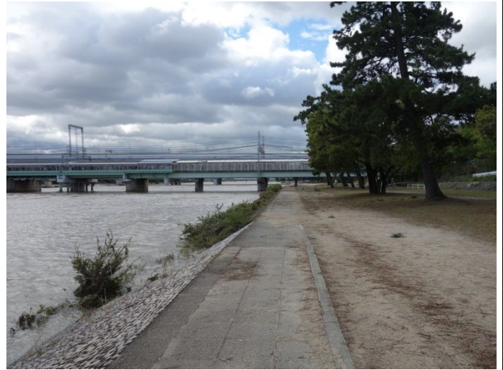
阪神橋梁右岸上流側 2017.10.23
