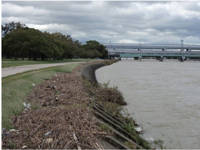
阪神橋梁左岸上流側 2017.10.23
