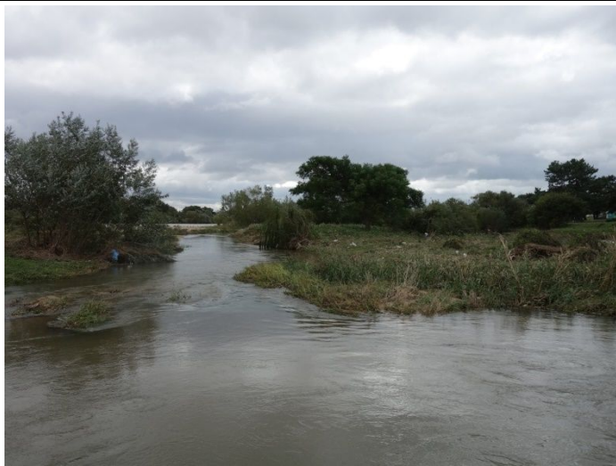
仁川潜水橋下流方向 2017.10.23
