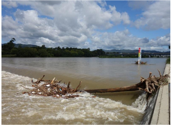
同左 甲武橋水標付近
