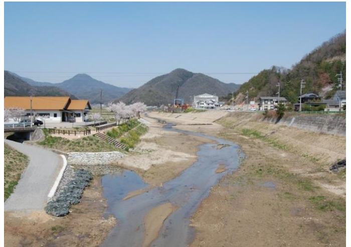
参考写真 平成21年改修工終了直後の草野
