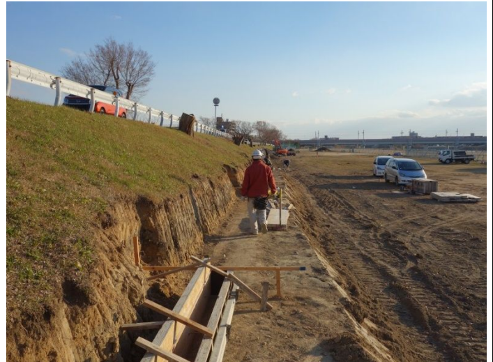
尼崎東工区堤防強化工事（アキニレとキョウチクトウ伐採された）
