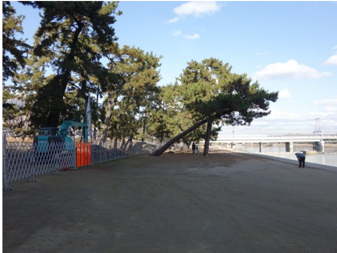
東鳴尾工区堤防強化工事始まる（浸透対策と拡幅矢板打ち）
