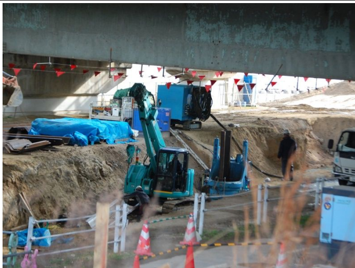
43号線橋梁下で継ぎ矢板打ち工法が採用されていた。
