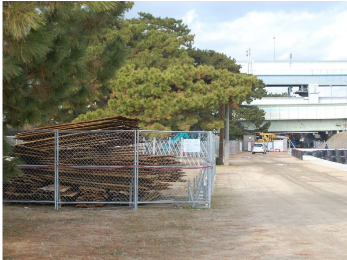
塩水浸透対策（引き抜かれた旧矢板）
