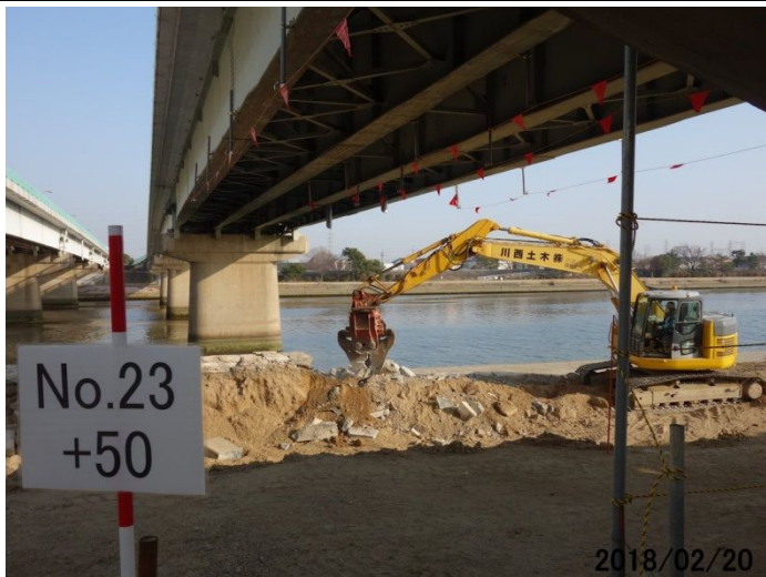
43号線橋梁付近で護岸ブロック破碎撤去の様子
