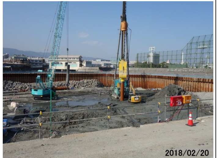
今津水門の杭打ち工事。軟弱地盤で短時間で入っていく
