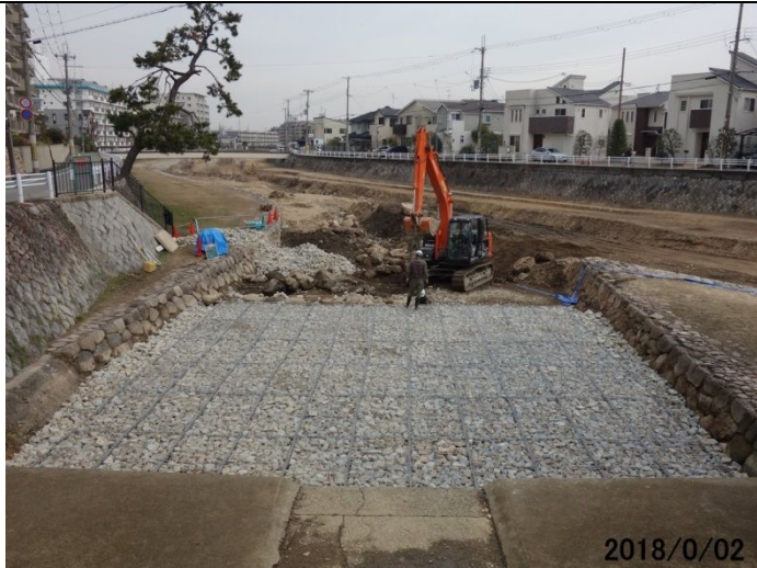
仁川・小仁川合流点の改修状況 雑木全部伐採された。
