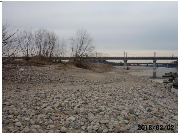
7号堰浚渫工事前の堆積状況
