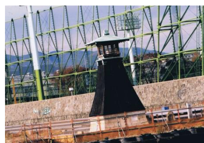
写真4 インフラ整備工事で移転される今津燈台
