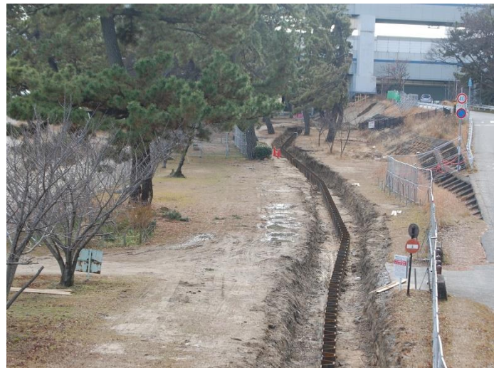
巧みに松を避けて打ち込まれた矢板
