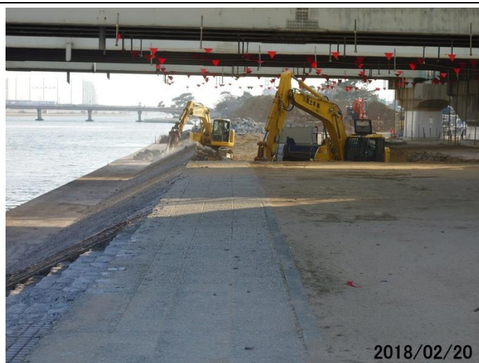
43 号線上流側から見た護岸ブロック破碎撤去の様子
