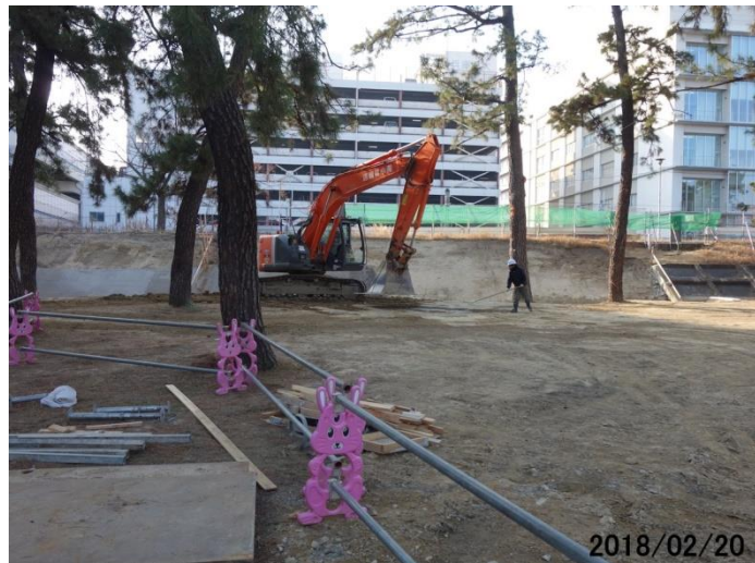
43 号線上流側 塩水浸透対策旧矢板打ち+堤防強化工事
