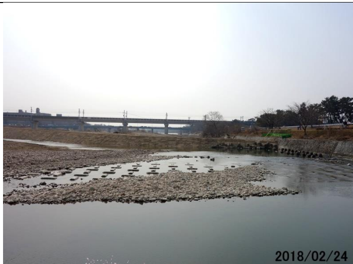
7号堰下流の堆積土砂浚渫工事が始まった
