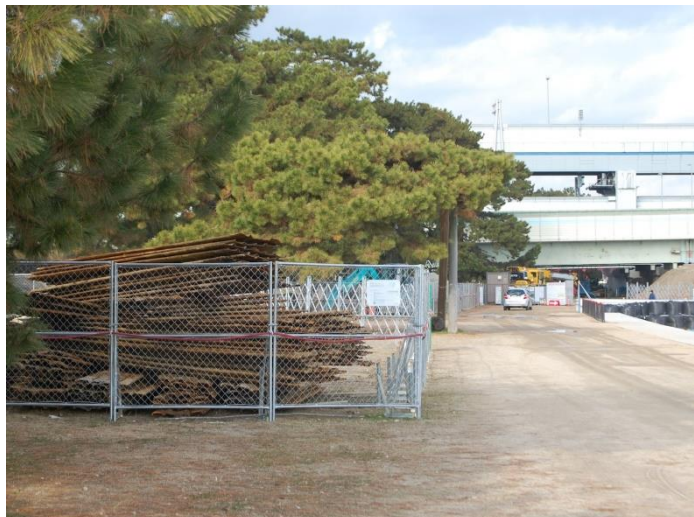
塩水浸透対策 (引き抜かれた旧矢板)
