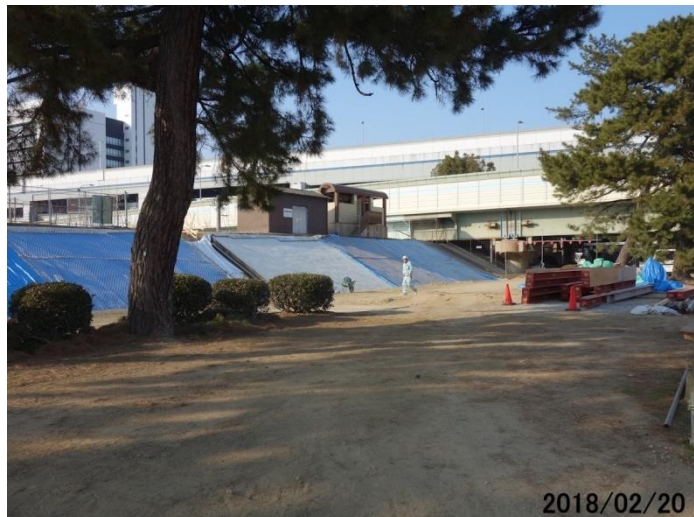
43 号線下流側 塩水浸透対策旧矢板打ち+堤防強化工事
