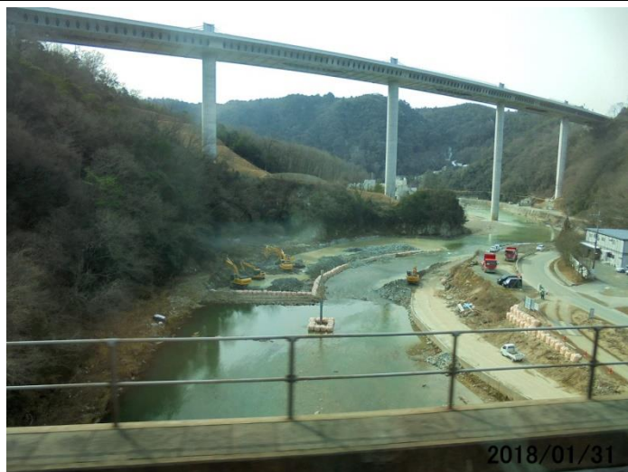
道場水標付近で河床掘削工事中（JR車中から撮影）
