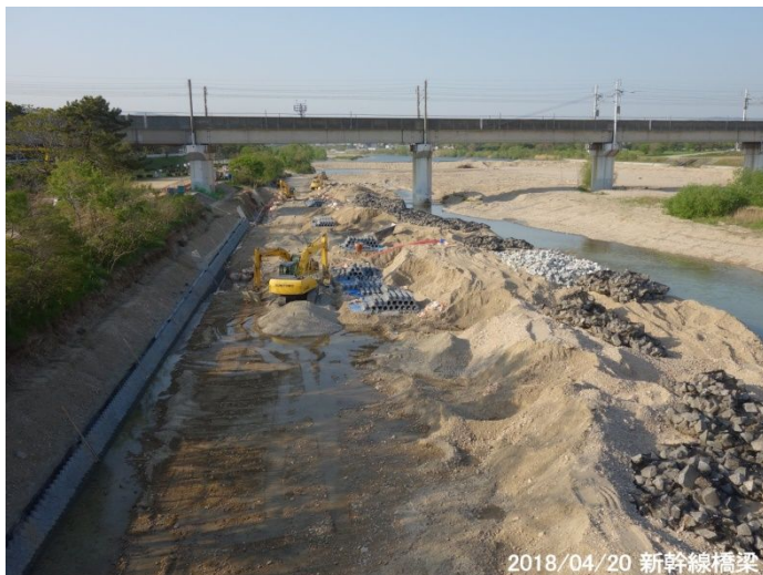
新幹線橋梁右岸護岸復旧工事の様相
