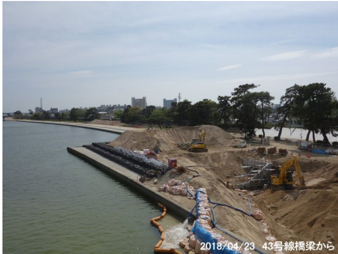
43号線橋梁下拡幅工事の様相
