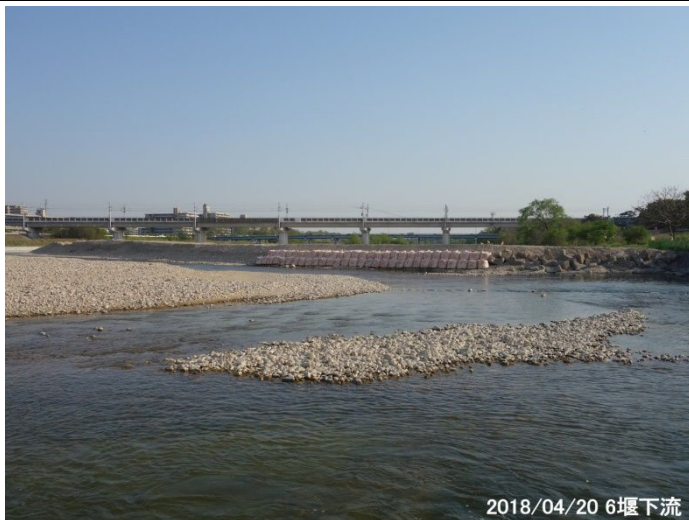
全量左岸寄りに流れるような仕切り堤体。
