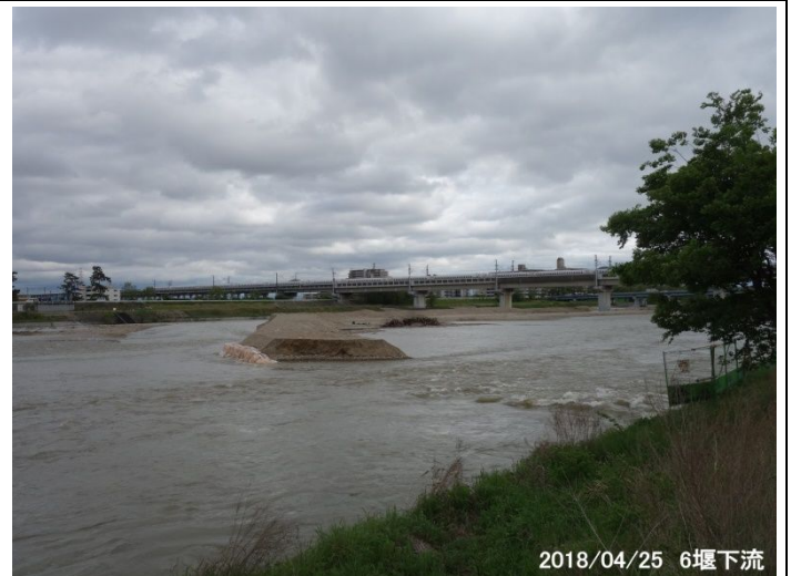
24～25日間の降雨後に仕切り堤体が切れていた。原因不明
