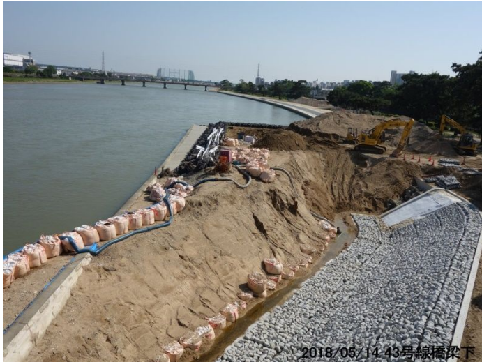
43号線橋梁下護岸工事の様
