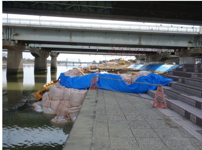
43号線橋梁下拡幅工事の様
