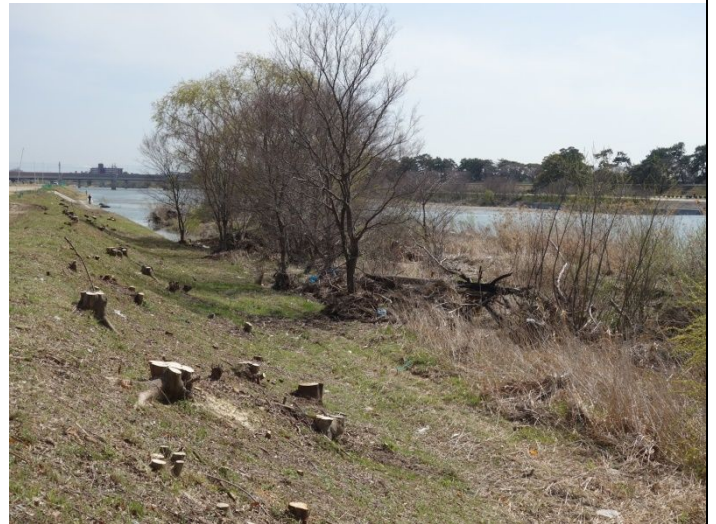
5堰上流左岸の雑木伐採状況
