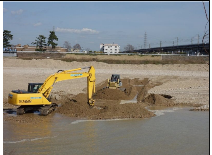
甲武橋上流側の押土工事（滞砂の平坦化工事？）
