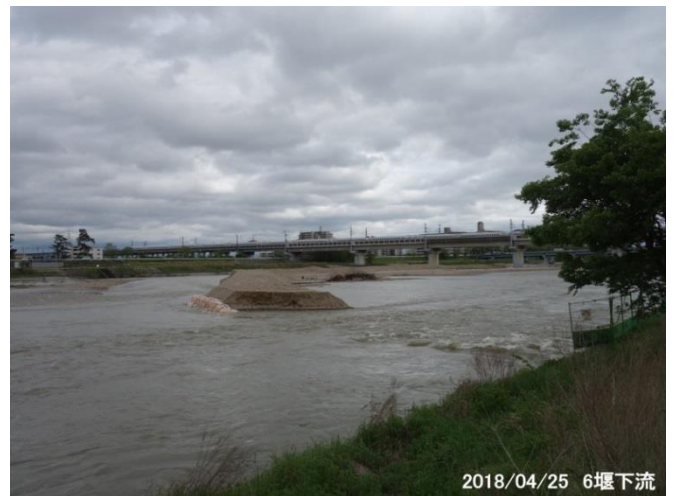
24~25日の降雨後に仕切り堤体が切れたが原因は不明
