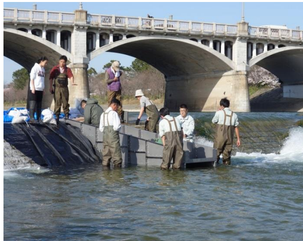
第2号堰で進む手づくり鋼製アート魚道づくり
