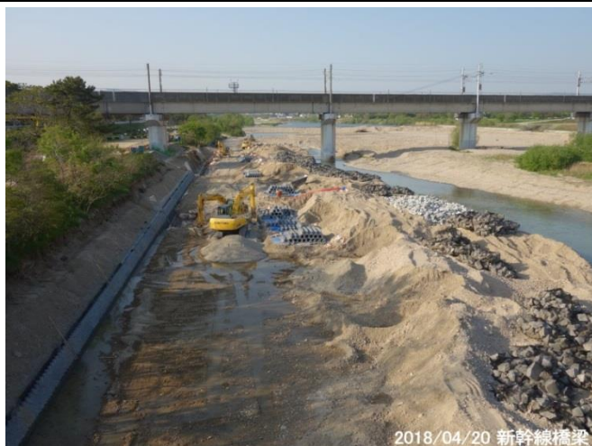
新幹線橋梁右岸護岸復旧工事の様
