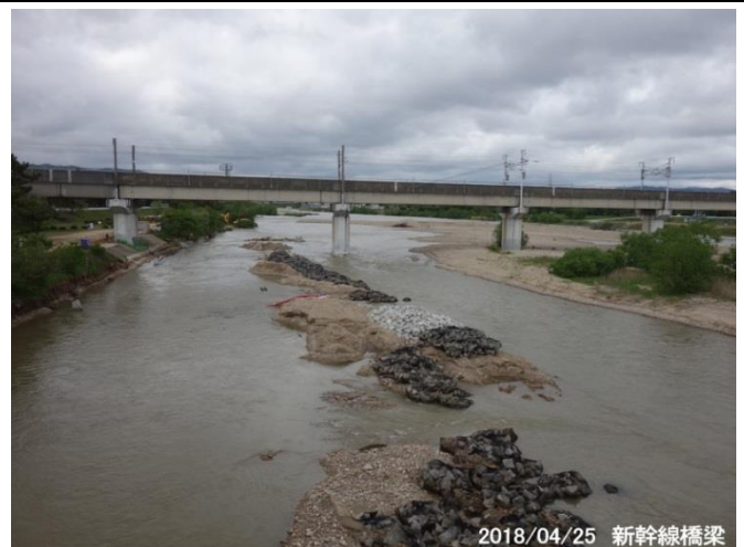
24~25日の降雨後の状況 工事は中断中
