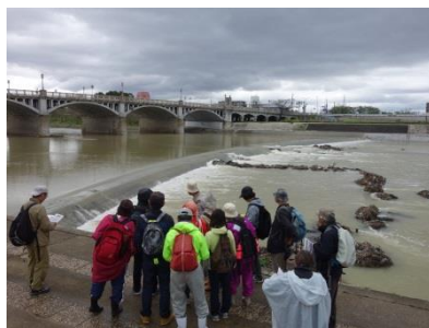
写真4 鋼製魚道・床止工の説明
