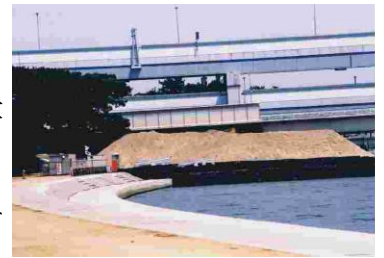
写真1 河川改修工事現場
