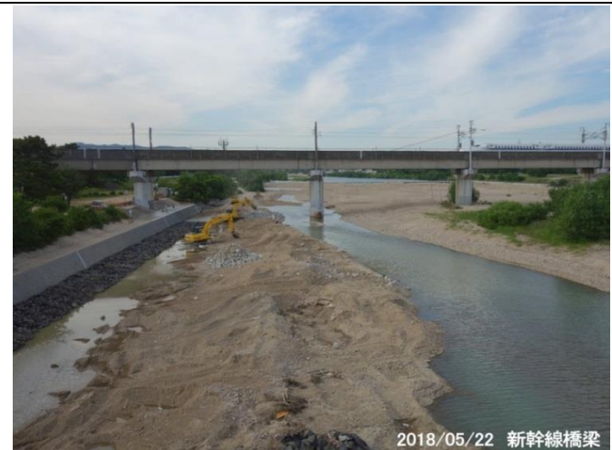
袋詰め玉石が敷き詰められ工事も終盤に入った
