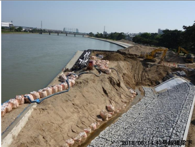
43号線橋梁下護岸工事
