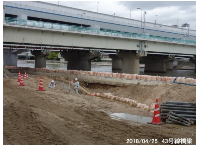
作業員の立っているところが新たな低水護岸になる
