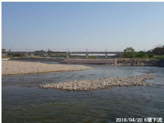
全量が左岸寄りに流れるような仕切り堤体
