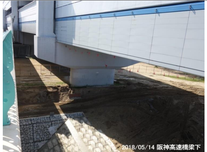
河川拡幅区間の末端で埋め立て工事が始まった
