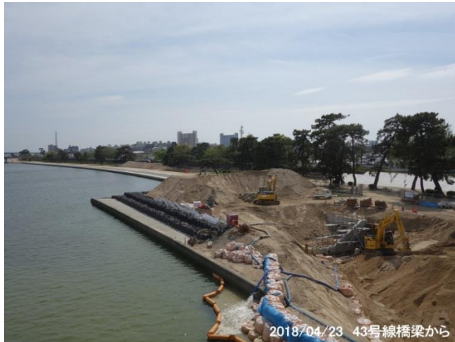
43号線橋梁下拡幅工事
