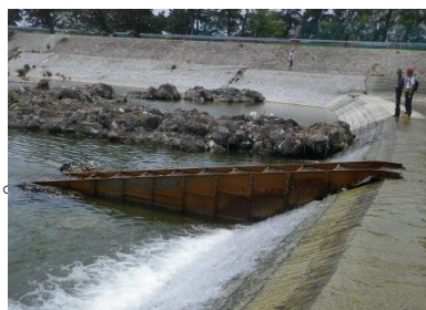
写真5 鋼製魚道(人工魚道)
