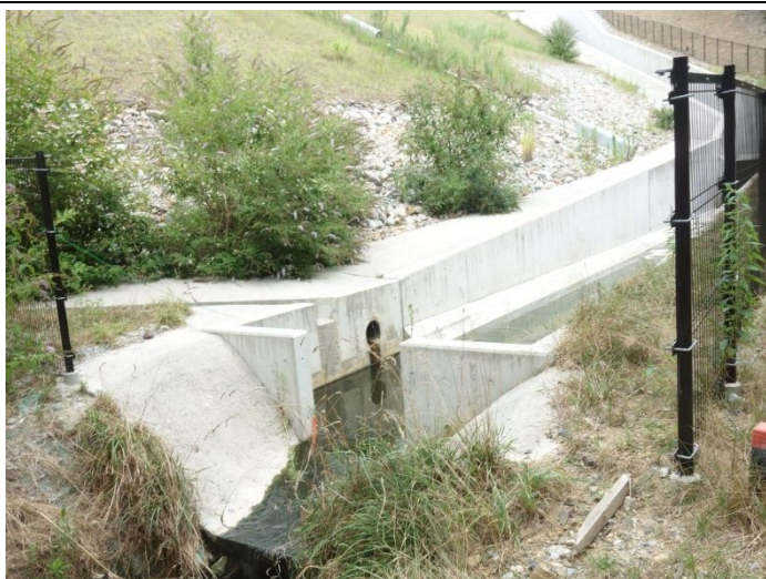
細い沢筋に流れへの放流堰（何故か三角堰が有った）
