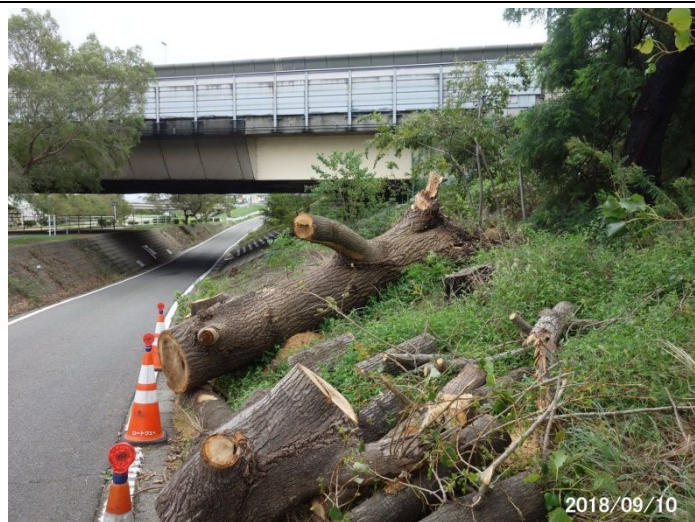
名神橋梁右岸の樹齢 25 年の榎倒壊、根っこが堤防傷める
