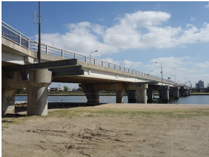
南部橋架設歩道橋工事始まる。
