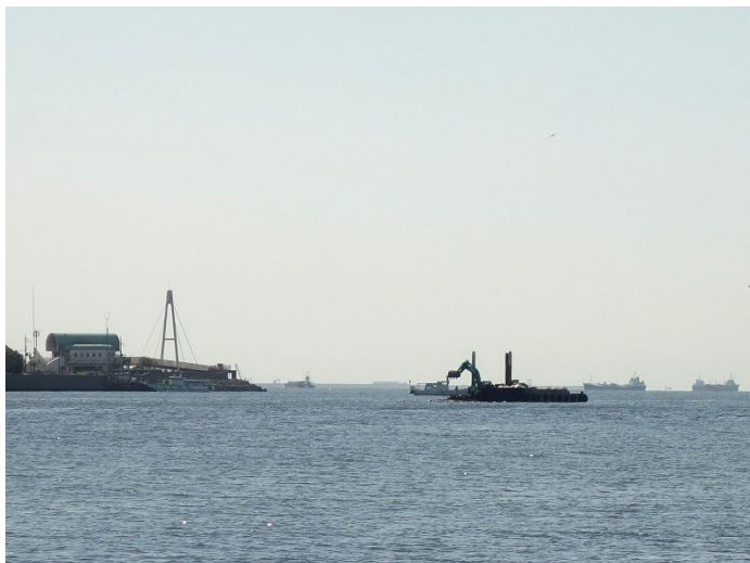
海釣り公園付近の浚渫工事
