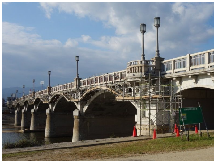
近代産業遺産甲武橋の補修工事が始まった
