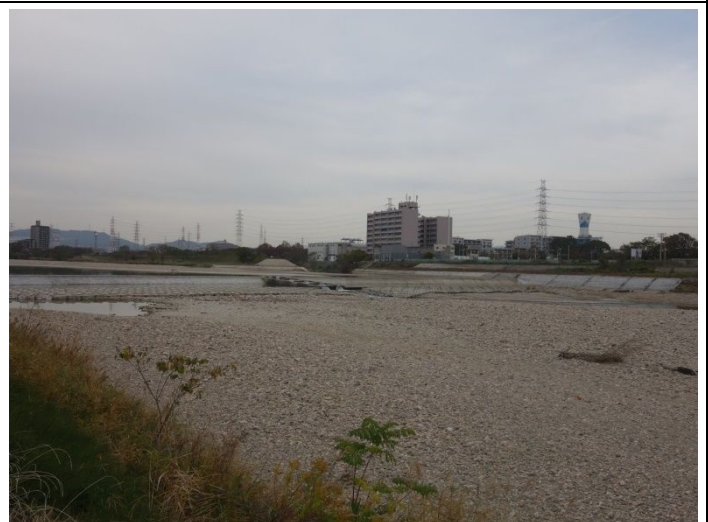
8号堰下流の堆積土砂撤去工事区域の現状
