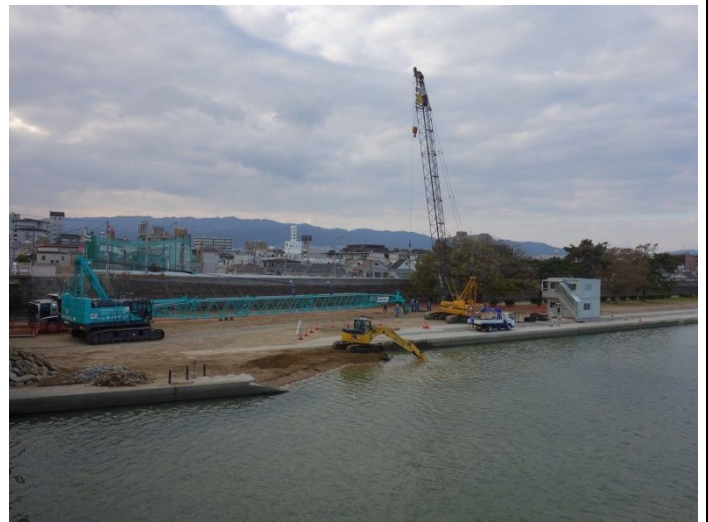
南部橋架け替え工事で新しい橋脚工事準備が始まる
