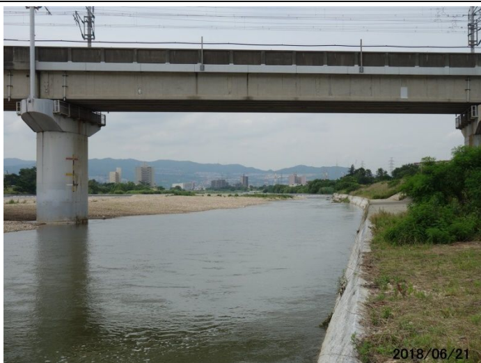
流れが集中する新幹線橋梁左岸側護岸側
