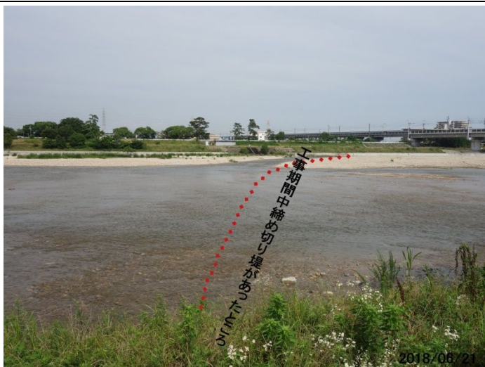
締め切り堤撤去、砂州は残り左右に別れた流れて洗屈が心配
