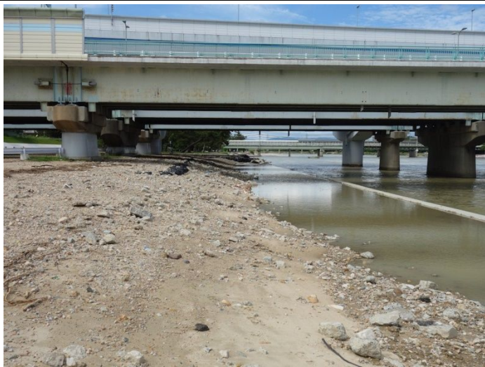
5月末に埋め戻された43号線橋梁下高水敷
