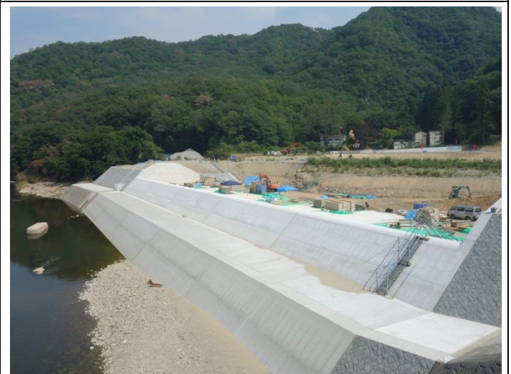
遊水地工事現場、今回の洪水では越流は無かった。
