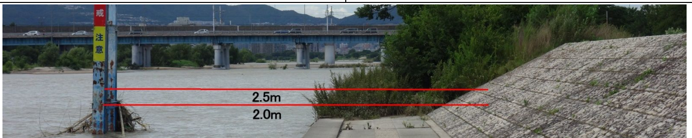
甲武橋水位は長雨で60時間も水防団待機水位（2.2m）前後で推移した。
