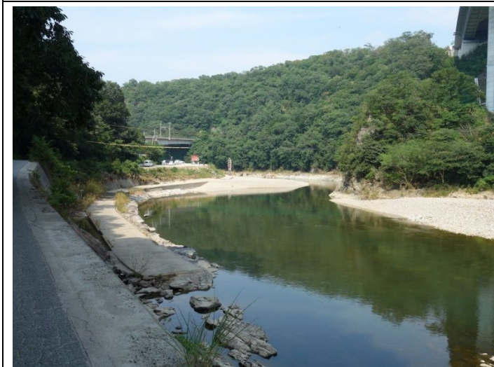
今年河床掘削を終えたばかりの河床に掘削前より高く砂礫堆積
