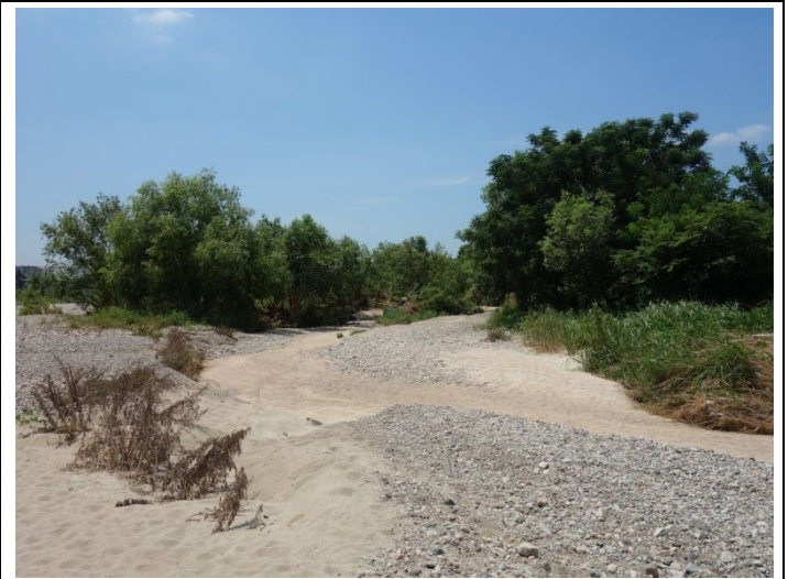
砂漠状態になった洪水後の潜水橋下流側
