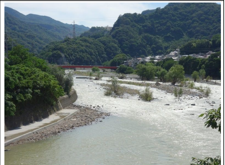
森興橋から瀬付け替え工事区間方向を望む
