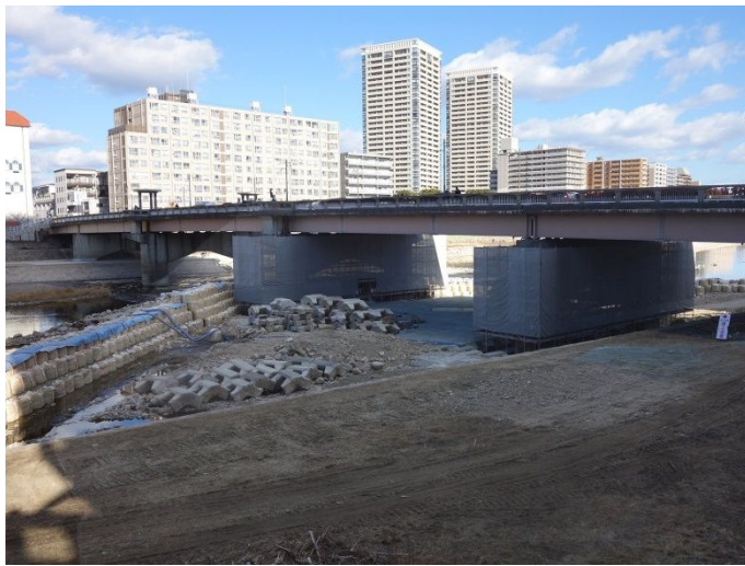
宝塚大橋橋脚補修工事
