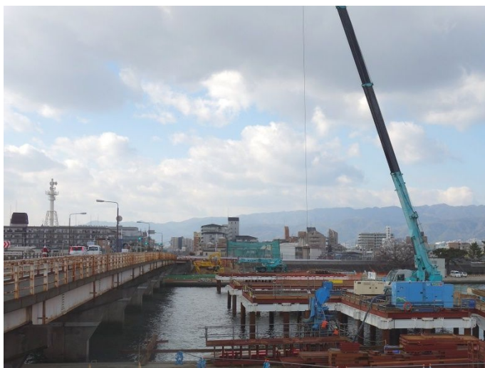
南部橋架け替え工事
