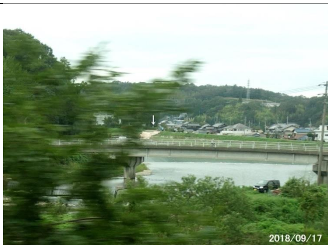
車中からでよく分からないが有馬川堤防表面が洗われた
