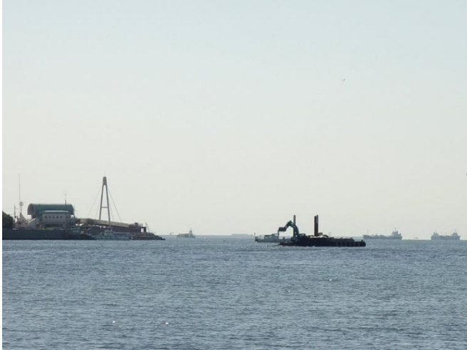
海釣り公園付近の浚渫工事
