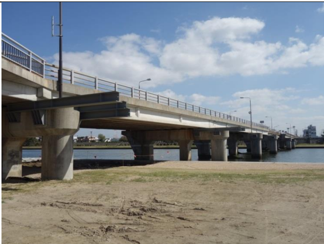
南部橋で架設歩道橋の工事が始まる
