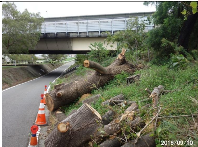
名神橋梁右岸の樹齢25年の栂檀が倒壊、根が堤防を傷める
