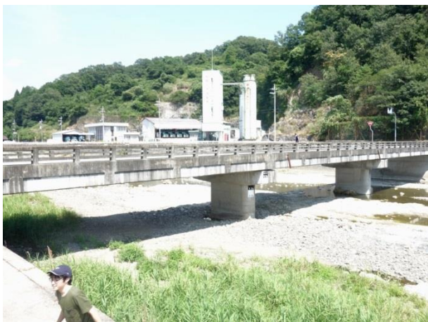
調査ポイントの大願寺橋、極端に水量が少ない
