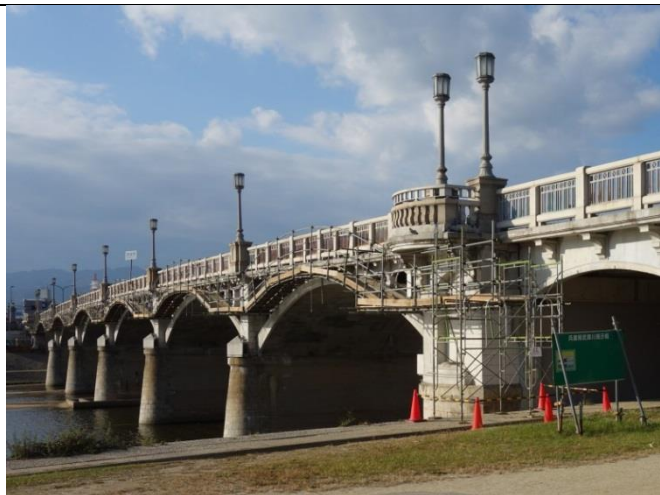
近代土木遺産武庫大橋の補修工事が始まった
