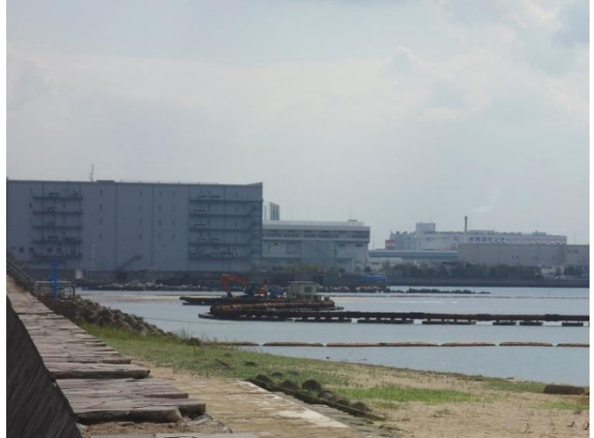
甲子園浜干潟再生工事（武庫川の浚渫土砂が使われる）
